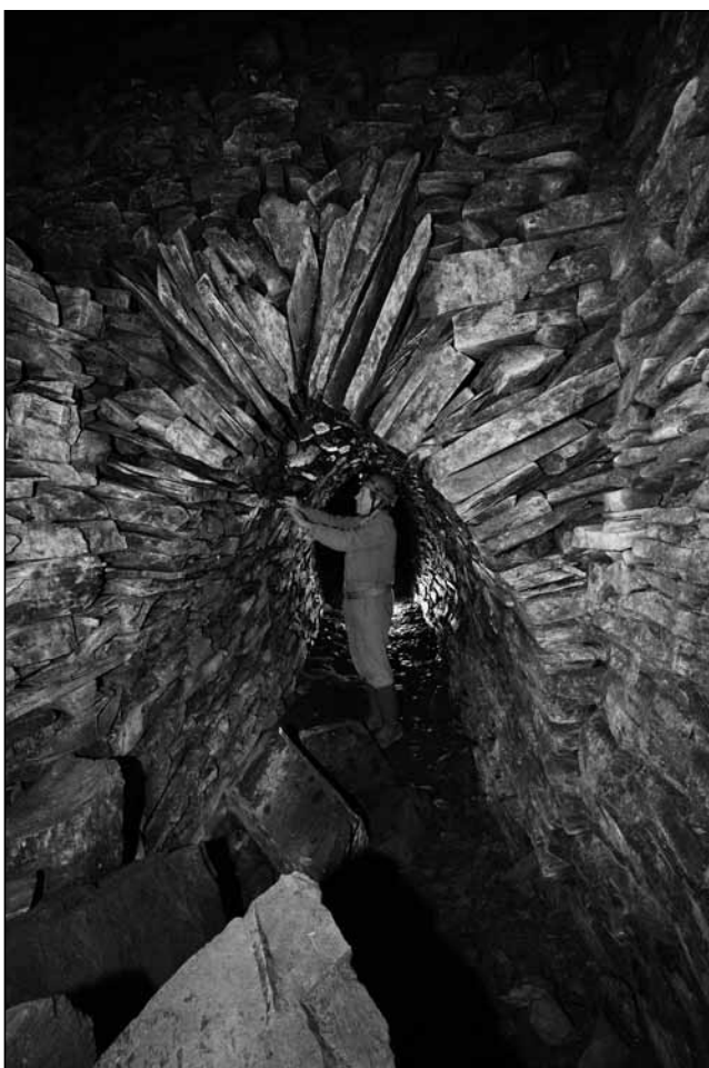
Chodba vyskládaná ve tvaru gotického oblouku, štola Nový Svět B (Foto Josef Wagner, 2019).
