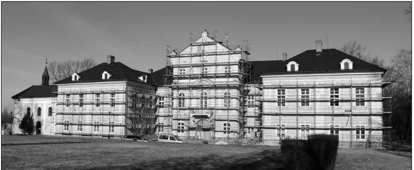
Zámek Nová Horka, čelní fasáda, stav během rekonstrukce (Foto Radek Polách).
