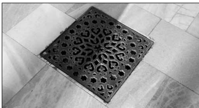
Dlažba ve vstupním vestibulu, stav před rekonstrukcí (Foto Radek Polách).
