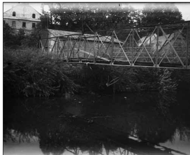
Květinová lávka poškozená výbuchem po pokusu o její vyhození 6. 5. 1945 (Foto Otto Brussmann SFEM ).
