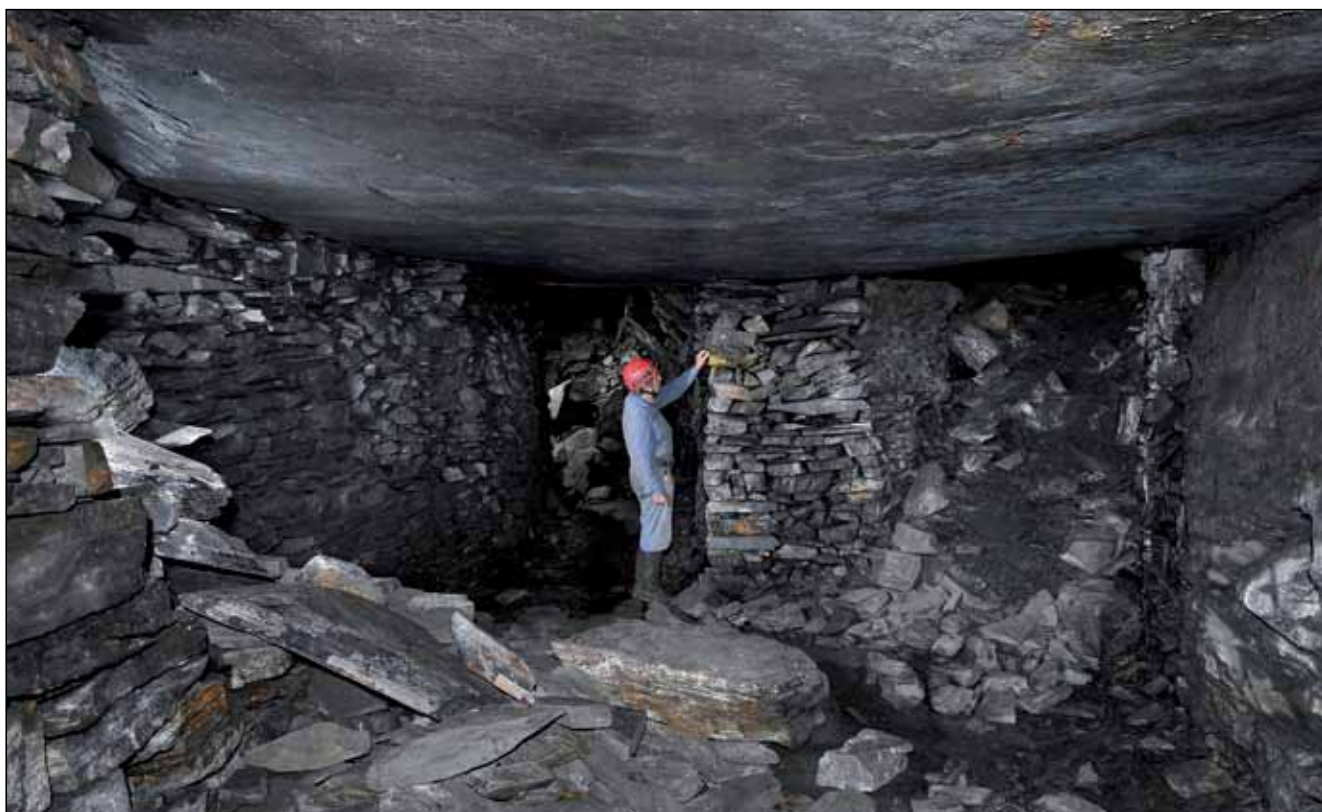
Vyskládané opěrné zdi podírající horizontálně uložené nadložní vrstvy hornin, štola Nový Svět C (Foto Josef Wagner, 2019).
