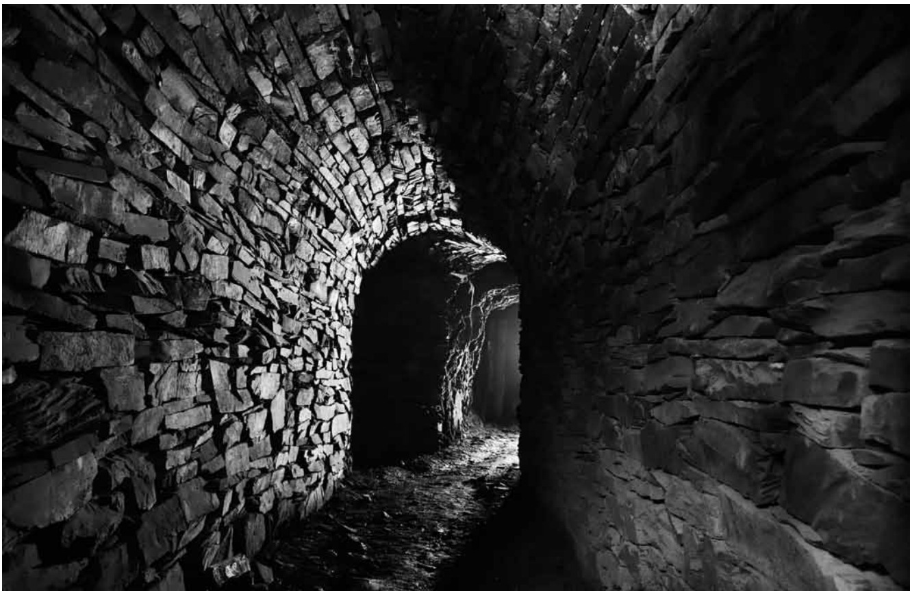
Vyskládaná chodba vybudovaná při zpřístupnění dolu ve štole Nový Svět B v místě částečně zborcené původní důlní chodby (Foto Jiří Spáčil, 2020).
