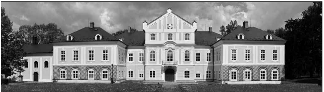
Stav po rekonstrukci (Foto Karel Kita).
