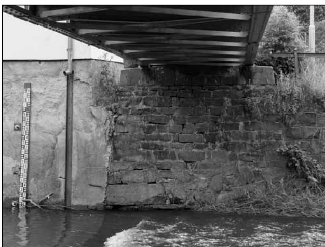
Poruchy a chátrání mostní konstrukce a pilířů (Foto Emil Mateiciuc).
