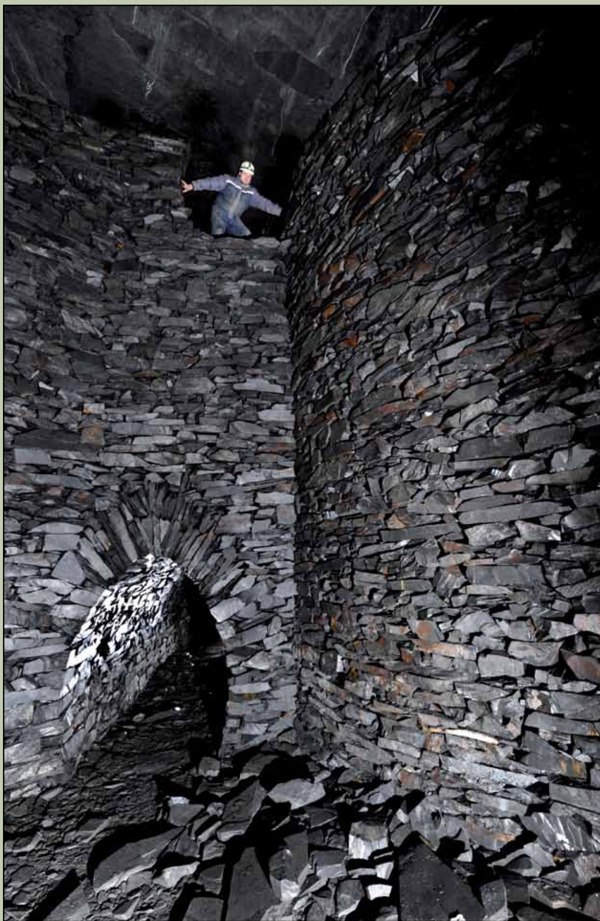
Flascharův důl – opěrná zeď a chodba ve štole Nový Svět B (Foto Josef Wagner: 2019).
